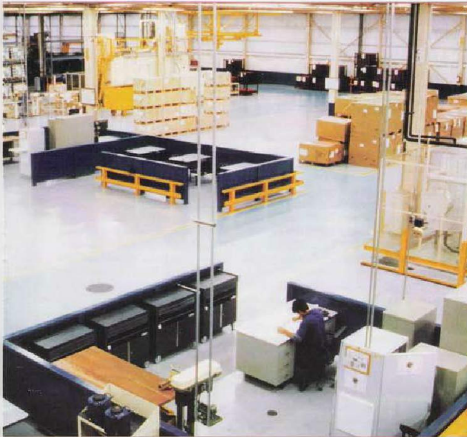
Centros de distribuição requerem tecnologia específica para implantação do piso ideal
