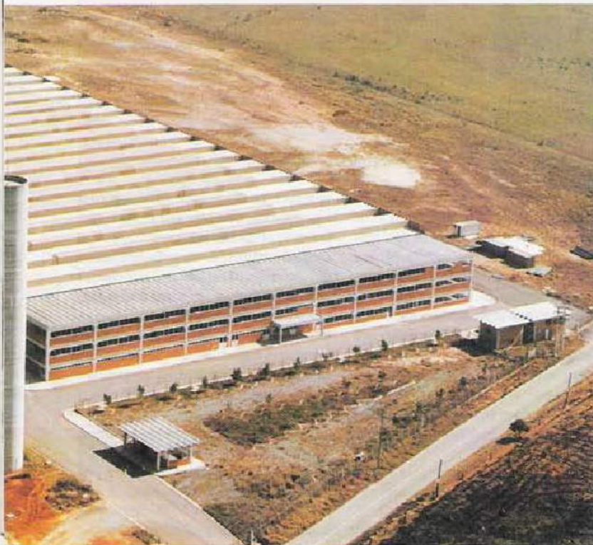
ber sistema de automação
